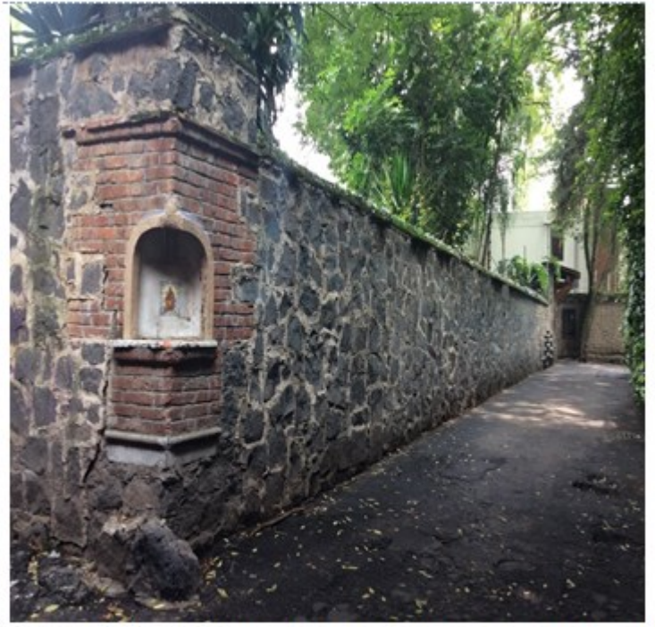
Pared de tipo basáltico, al fondo es dónde se encontraba el árbol del aguacate Fotografía propia.
